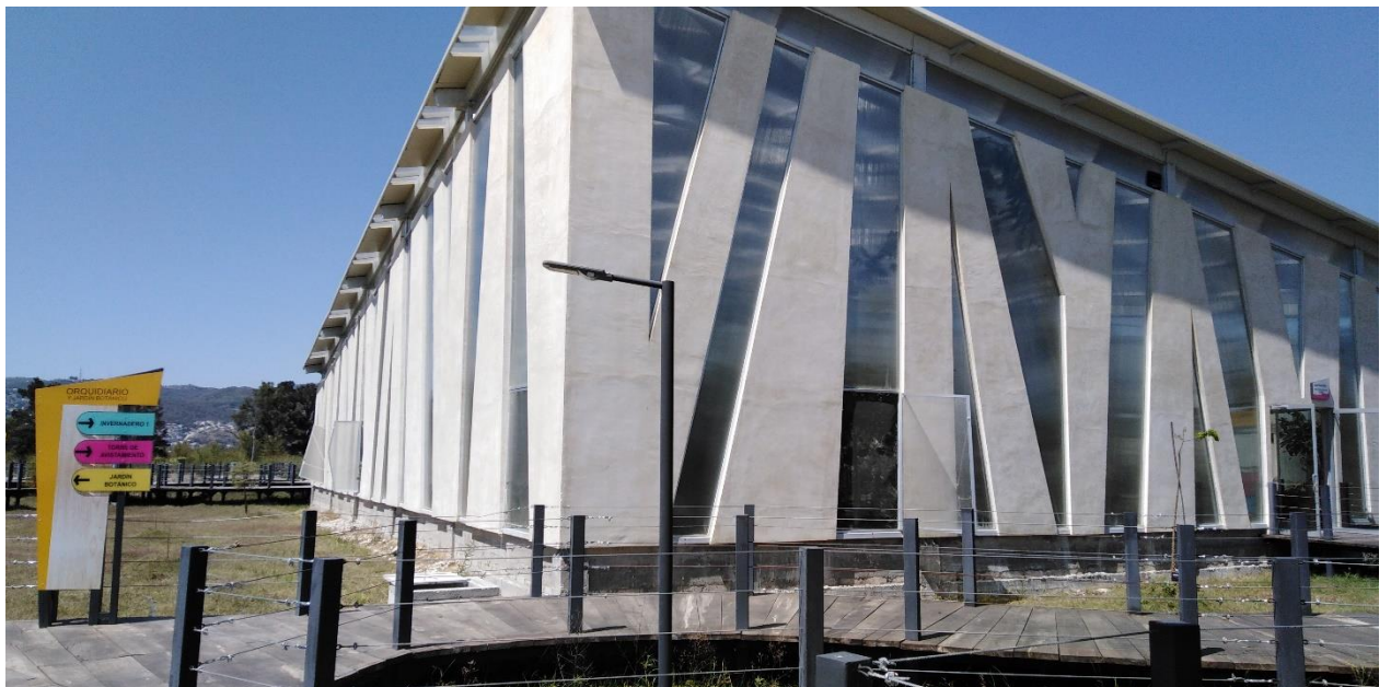
Fotografía 4. Edificio principal del orquidiario
